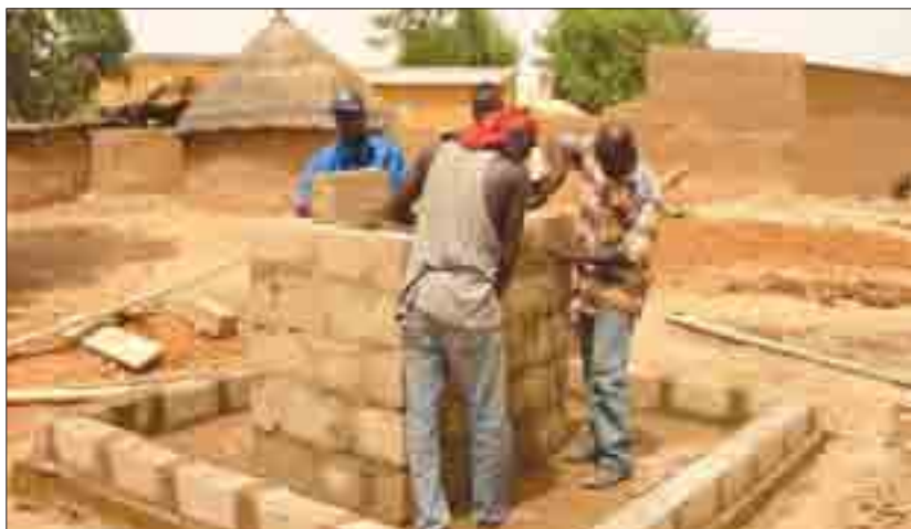
▲ Les travaux de construction du château d'eau de Soaligou. Cet ouvrage alimenté par la PTF va réduire la corvée d'eau.
